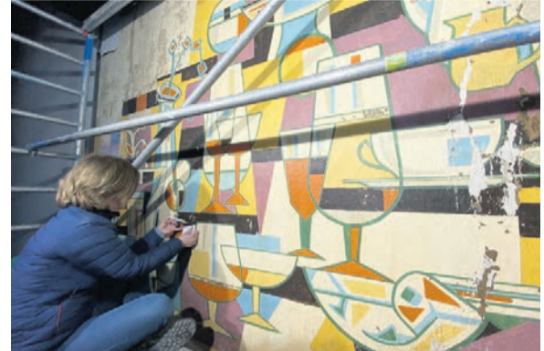
Restaurator Angélique Friedrichs verwijdert glasvezelbehang en legt muurschildering bloot FOTO: SRAL
